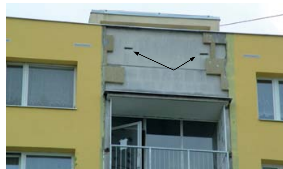
Obr. 17: Příklad úkrytu netopýrů v panelovém domě, který je při zateplování budov ohrožen.
