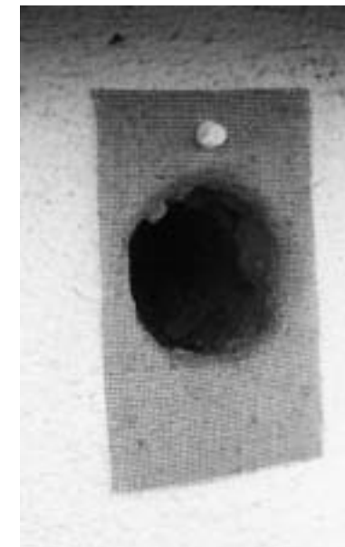
Obr. 18: Příklad jednoduchého zabezpečení vyletového otvoru, které současně zamezuje návratu netopýrů. Foto: M. Celuch
