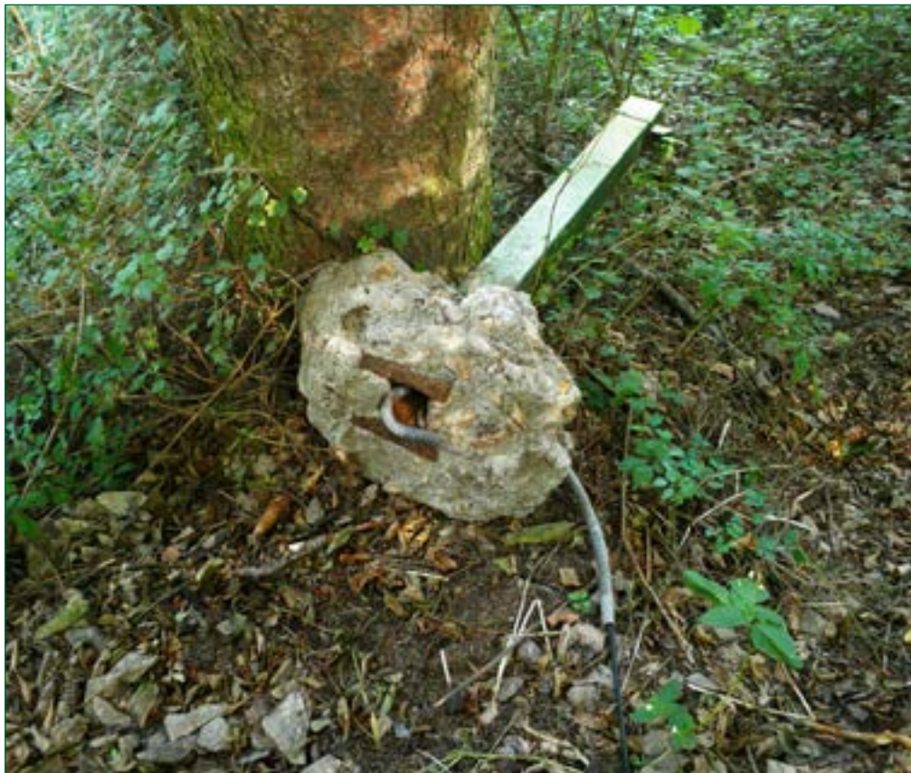
Ukázka poškození viditelného sčítacího zařízení vandaly. Foto: David Zahradník
